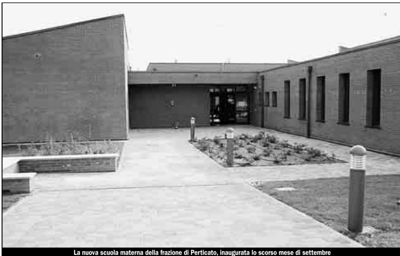
La nuova scuola materna della frazione di Perticato, inaugurata lo scorso mese di settembre
